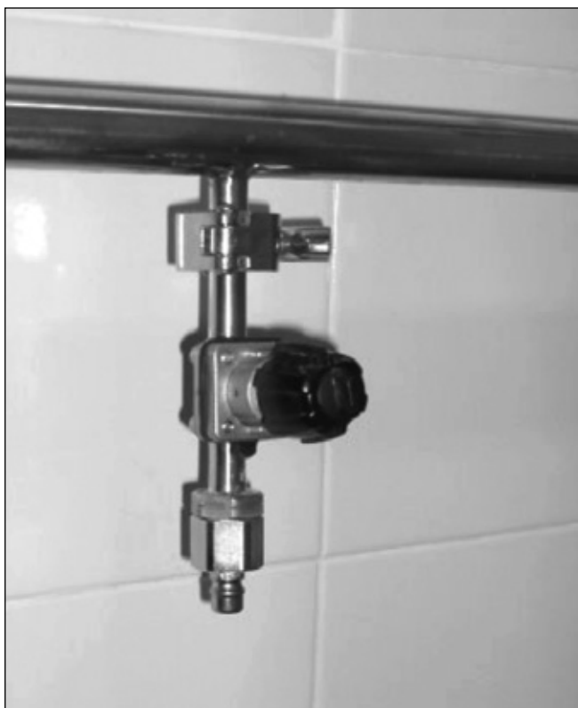
Fig. 1 - Uno stacco in acciaio INOX AISI 316 L.
